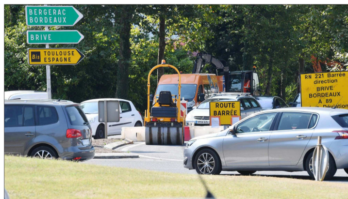
Des déviations seront prévues le temps des travaux. PHOTO ARCHIVES DL
