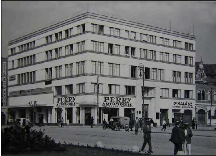
Palatul Bursei de Valori din Cluj, construit de Camera de Comerț și Industrie din Cluj. Aici și-a avut sediul, în perioada interbelică, reprezentanța Uzinelor Ford în România, Perry Automobile. După război, clădirea a fost repartizată Armatei (Casa Armatei, Cercul Militar de azi).
