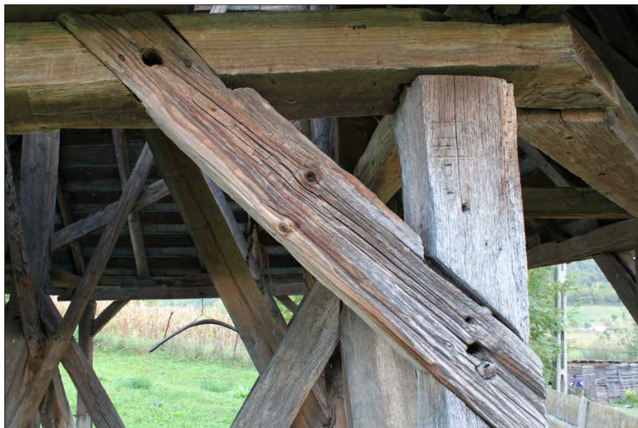
Semne făcute pe grinzile clopotniței (în prim plan: patru linii), făcute la mutarea din curtea fostei biserici de lemn. Foto: Bogdan Ilieș
