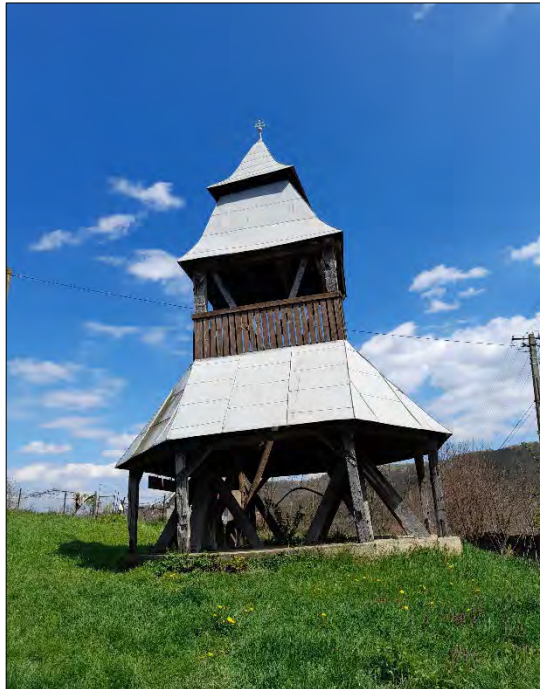
Clopotnița bisericii, după mai multe consolidări și renovări. Foto: Doina Rad
