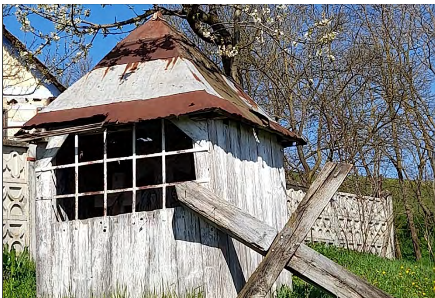
Troița de la intrarea în sat, veche de peste 100 de ani. Nu se știe cine a făcut-o și când anume. Aici este înainte de refacerea acoperișului, cu vechea cruce alături. Foto: Doina Rad
