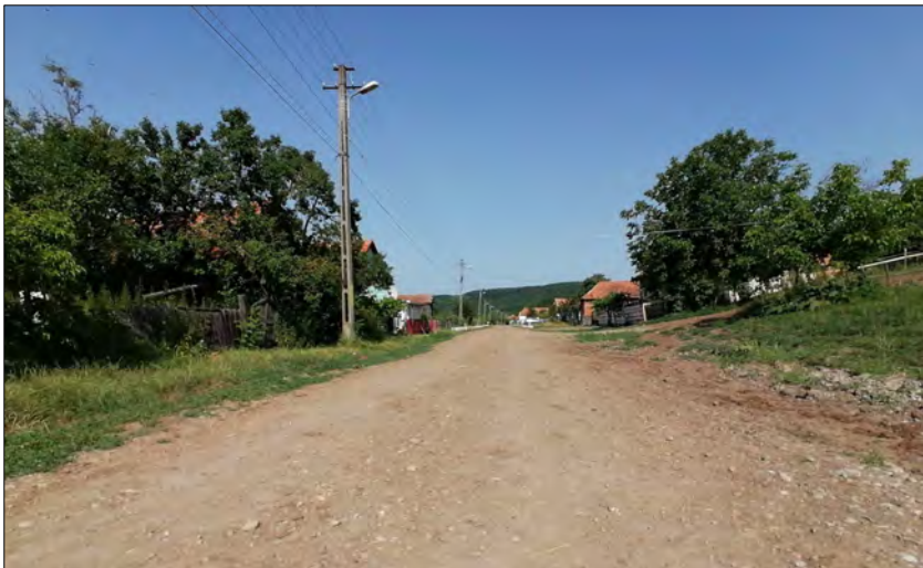
Porțiune din ulița După Curte , pregătită pentru asfaltare. Foto: Nicușor Rad
