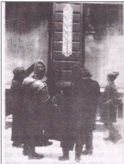
Termometru cu alcool, ce avea o înălțime de peste 6 m și măsura temperaturile de la -45°C până la +45°C
