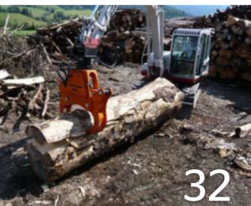
UTILAJE MULTIFUNCȚIONALE: TAKEUCH EXCAVATORS
