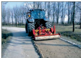
Renovarea unui drum de piatră
