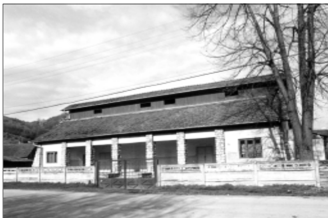
Clădirea Căminului Cultural
