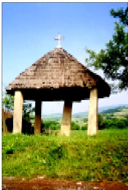
Rugă de hotar din piatră cu acoperiș din șindrilă în Roșcani
